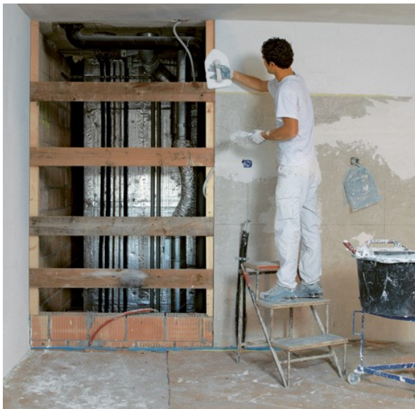
16 Gipsler beim Arbeiten an einer Wandöffnung
