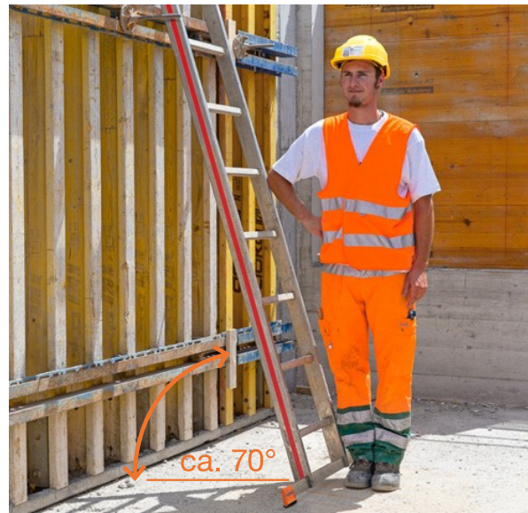
35 Überprüfen des Anstellwinkels mit Ellbogenprobe
