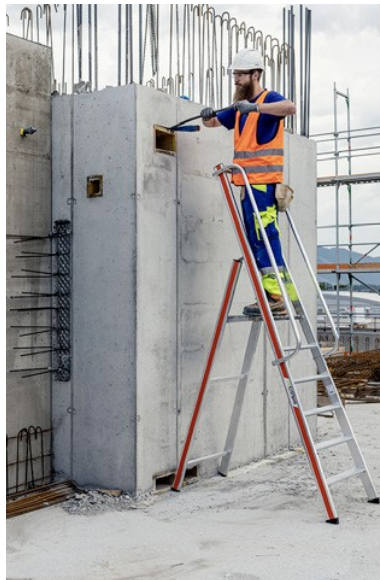
20 Bearbeiten einer Betonwand
