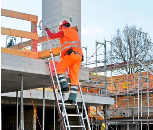
34 Verlängerte Leiterholme für einen sicheren Überstieg
