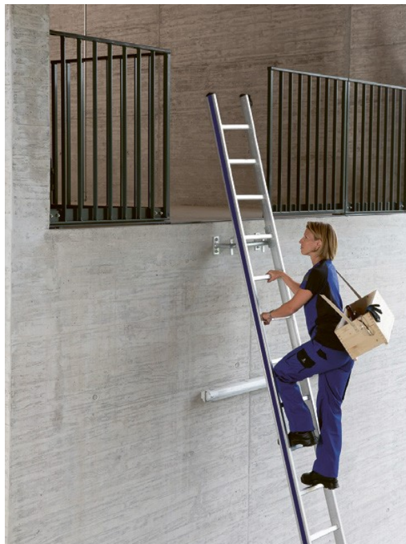
47 und 48 Blick und Körper zur Leiter richten, mit beiden Hände sicher an der Leiter festhalten, geeignetes Tragmittel (angehängte Werkzeugtasche bzw. Umhängekiste) mitführen.
